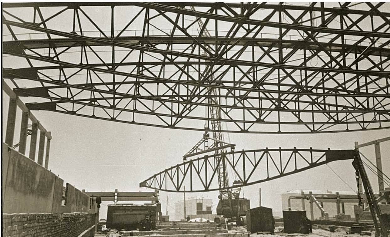
Строительство Дворца спорта на улице Р. Зорге. 1967 г.
